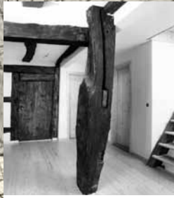
Typisches Merkmal des Hochstudbaus: mächtiger, durchgehender Ständer.
