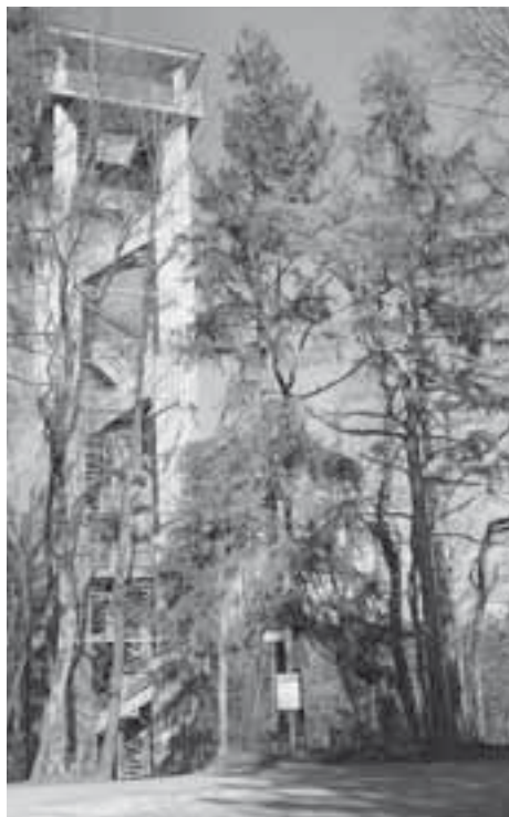
Links: Altbergturm ob Dänikon, erstellt 2010. Aufnahme Martin Bachmann, KAZ, März 2012. Rechts: Hochwachturm ob Wildensbuch (Gde. Trüllikon), errichtet 2010 nahe der Grenze zum Kanton Thurgau. Zustand April 2011. Privataufnahme.
