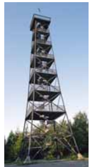
Eschenbergturm von 1889. Ältester begehbare Turm der Schweiz. Zustand August 2009. KDP Fotoarchiv.
