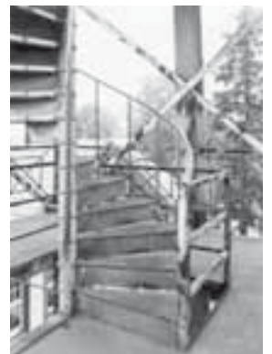
Wendeltreppe des Üetlibergturms. Zustand September 1983. KDP Fotoarchiv.
